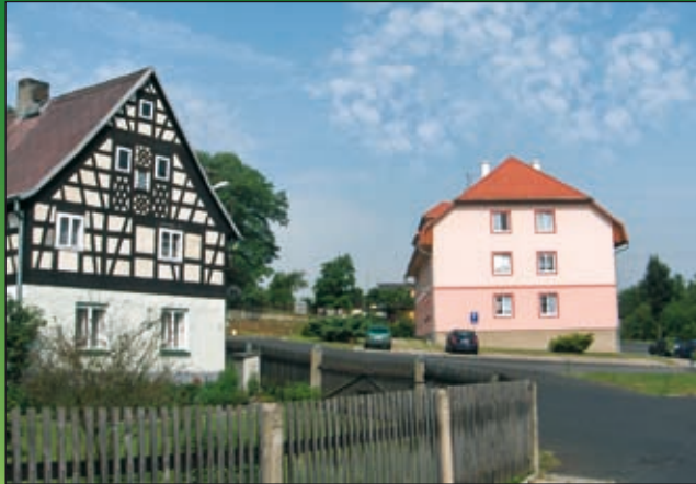
Hrázděný dům č.p. 19 a nový bytový dům č.p. 1 (2000)
